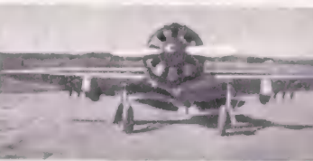
И-16 тип 29 с подвесными баками в РС.
